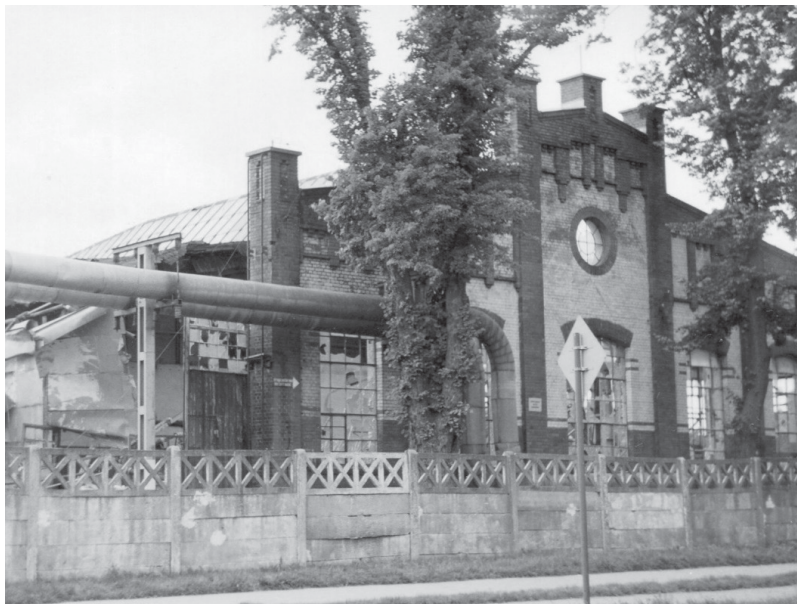
Fragment budynku wagonowni, w której mieścił się podobóz słupski, początek XXI w., już w okresie rozbiórki
