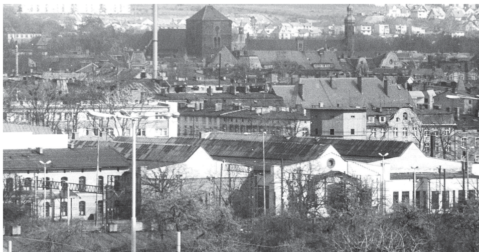
Widok ogólny na budynki Zakładu Naprawczego Taboru Kolejowego w Słupsku, w czasie wojny – Aussenarbeitslager Stolp (to niewysokie, długie budynki na pierwszym planie). Zdjęcie z przełomu lat 80/90. XX wieku
